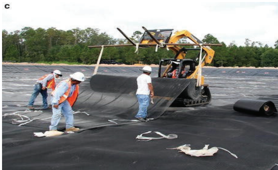
Slika 13: Detalj ugradnje geomembrane
