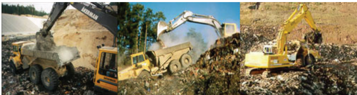
Slika 18 - Iskopavanje stabilizovanog tela deponije
