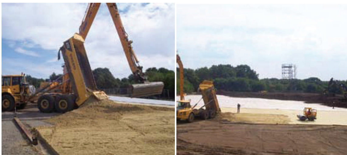
Slike 11 i 12 - Način ugradnje trisoplasta
